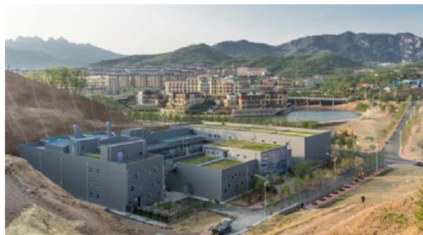
Semizentral-Anlage auf dem Gelände der Weltgartenbauausstellung in Qingdao, China
